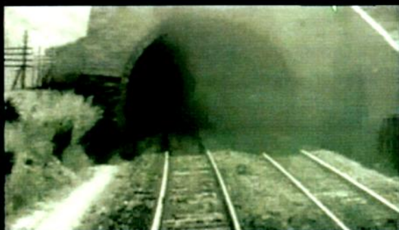
1^ GALLERIA FERROVIARIA del MONDO
